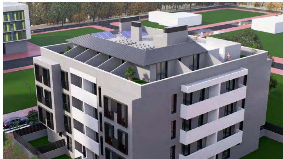
Fachadas Oeste / sur
